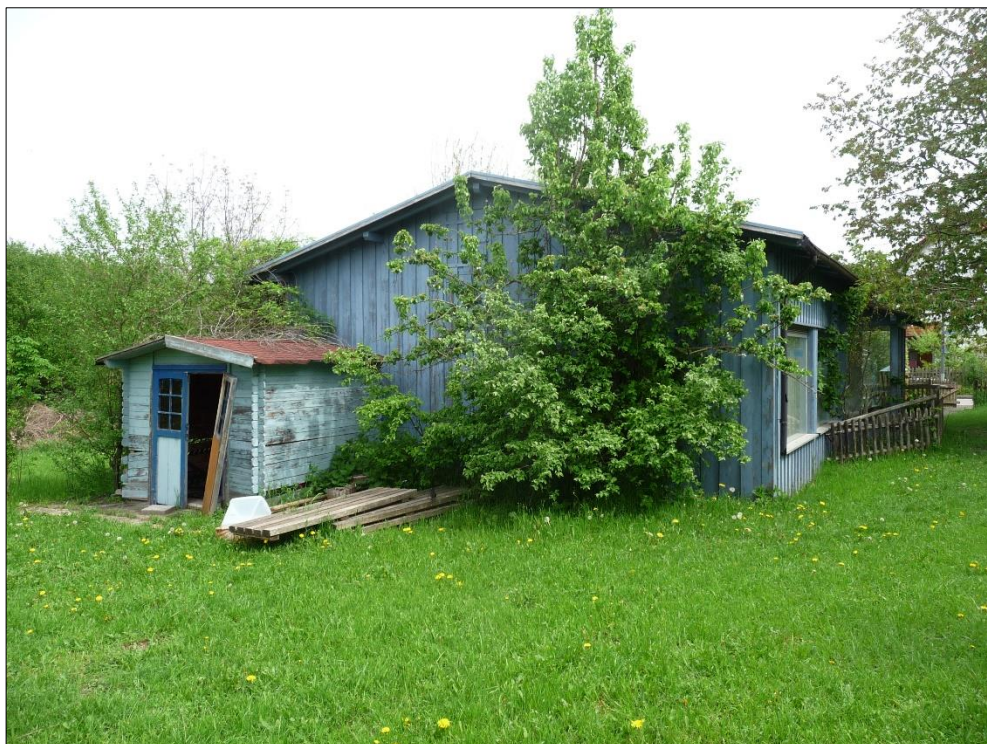
Abbildung 6: Bestandsgebäude auf dem Flurgrundstück 436/9 mit Wildbirnenbaum an der Fassade (Renner, 08.05.2023)
